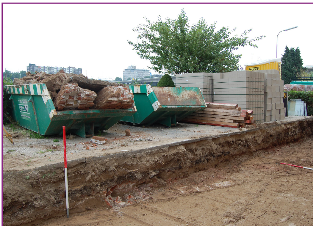
Afbeelding 10. Noordzijde van de uitbreiding van de bouwkuip. Zichtbaar de noordoost-zuidwestelijk georiënteerde muur met grondboogfundering. Foto richting noorden.
